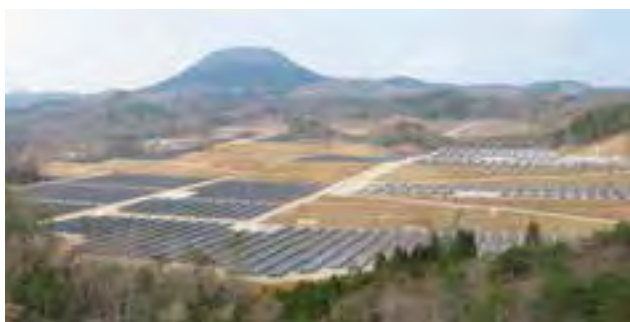
岡山県新見市の太陽光発電所事業地全景
