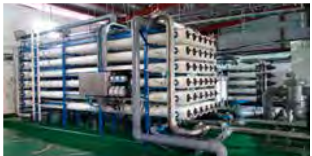
納入予定の設備と同規模の海水淡水化ROシステム
