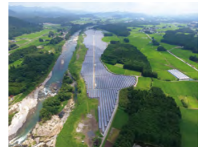
太陽光発電所(栃木県日光市)
