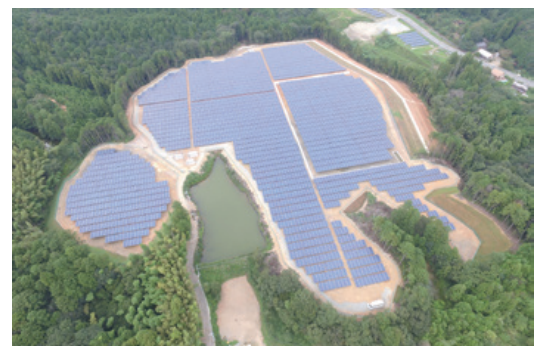
太陽光発電（三重県多気郡）
