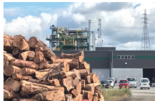
バイオマス発電（山形県米沢市）
