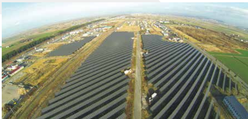
岩見沢太陽光発電所(北海道岩見沢市)
