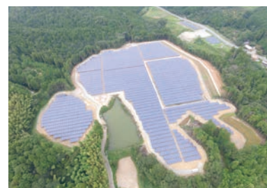
太陽光発電(三重県多気郡)
