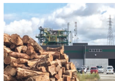
バイオマス発電(山形県米沢市)
