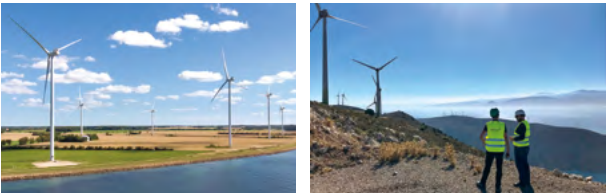
Aquila Capitalの運営する風力発電所
