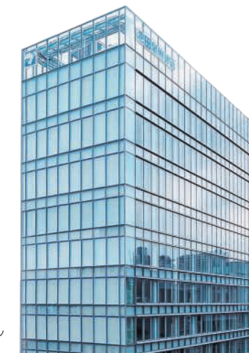
池田泉州ホールディングス本社ビル
