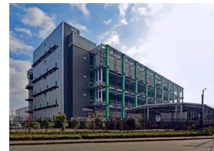
データセンター MFIP印西II
