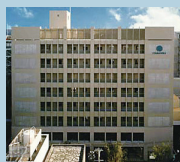
大丸京都店西館共同ビル
