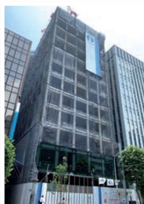
2020年6月時点 建築工事現場
