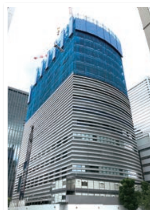
2020年6月時点 建築工事現場
