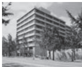
瓦町ビル 1962年竣工
