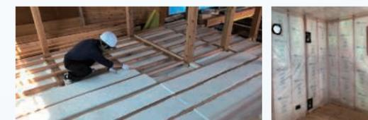
断熱材を床、壁、天井に施工している様子
