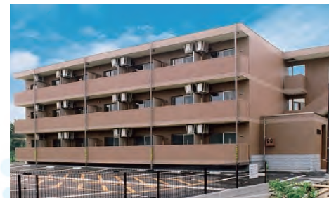
エフ・コンスパイヤー
