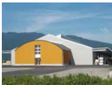
岐阜工場 3号棟(岐阜県養老郡)
