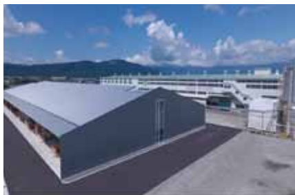
新プレカット工場（岐阜県養老郡）
