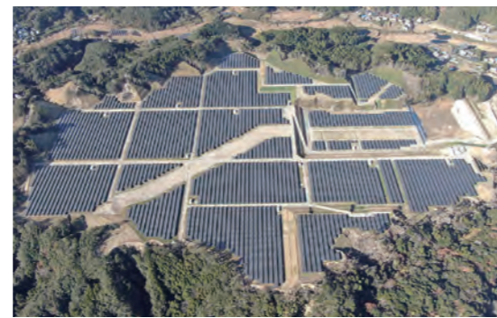
LS千葉勝浦発電所
