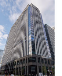
本社(鉄鋼ビルディング)
