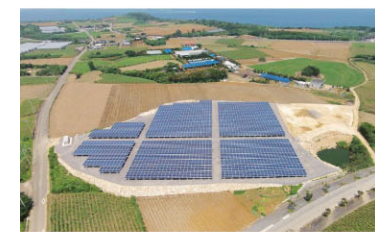
LS宮古島城辺発電所(沖縄県宮古島市)
