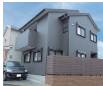
シックなグレーで統一された外観
