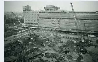
横浜駅西口に地下街を建設
