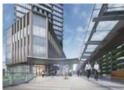
横浜駅直結の歩行者デッキ
