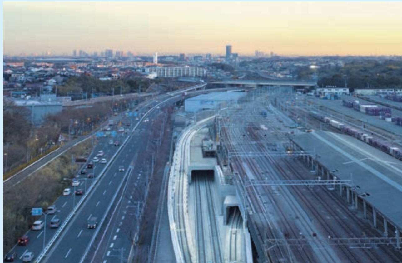
羽沢横浜国大駅付近。写真中央4線のうち、左右の2線が相鉄・JR直通線、中央の2線が相鉄・東急直通線
