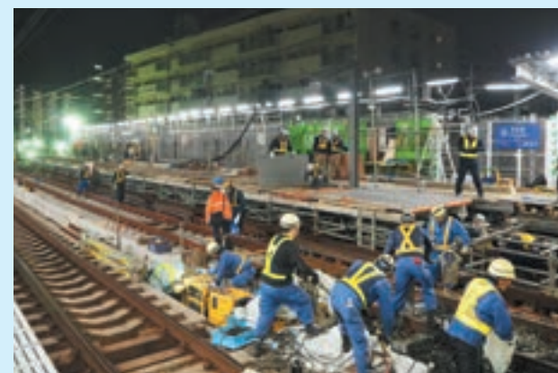
切替工事(天王町駅)
