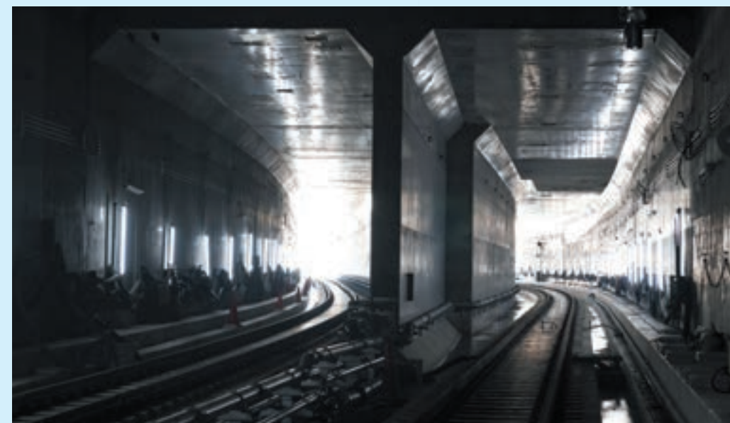
本線線路下で上下線が合流するトンネル部分(右が上り線)
