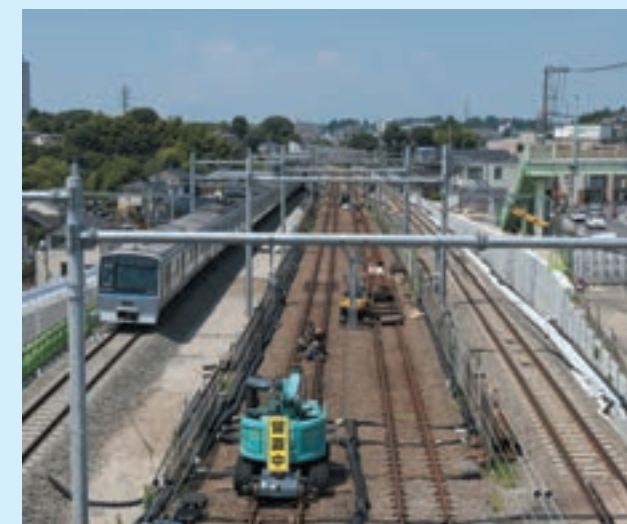
左右が新線路。上り線は3月3日夜間、下り線は7月14日夜間に切替工事を実施(左が下り線)
