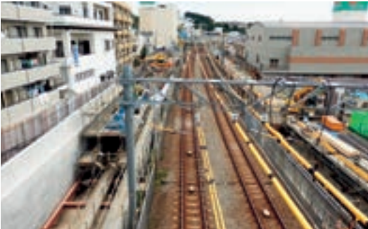
相鉄・JR直通線接続工事 西谷駅付近
