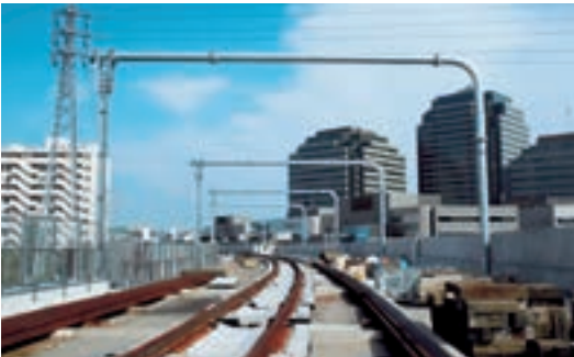
星川・天王町駅付近連続立体交差工事 高架部分
