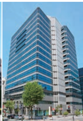
TSプラザビル(横浜市神奈川区)
