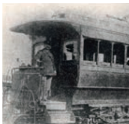
大師電気鉄道開業に向けて1899(明治32)年に導入された二軸木造電車
