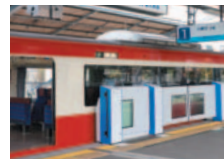
三浦海岸駅に設置した「マルチドア対応ホームドア(どこでもドア®)」
