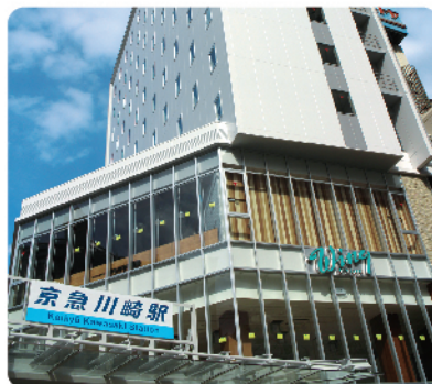
京急川崎駅直結の複合ビル
