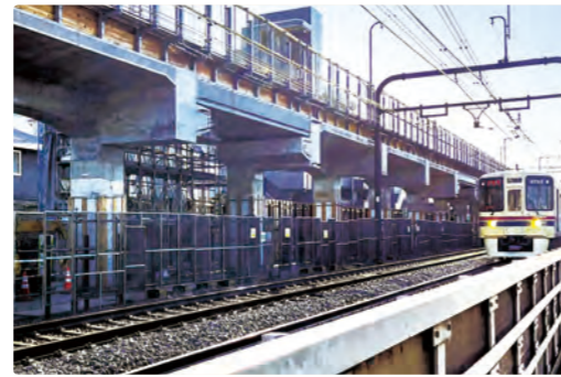
高架橋構築箇所(千歳烏山駅～仙川駅間)
