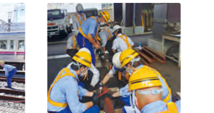
レールの応急復旧訓練
