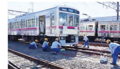
脱線車両の復旧
