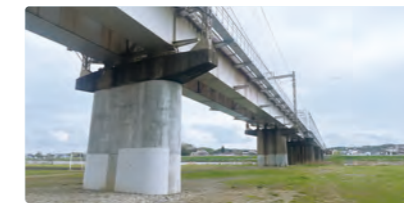
多摩川橋梁耐震補強
