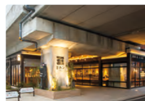
設計・施工した下北沢駅の高架下施設「ミカン北」
