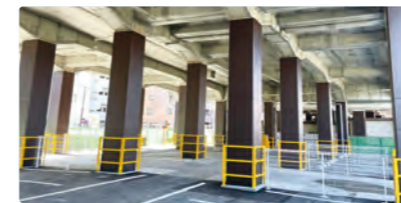
耐震補強を実施した高架橋柱
