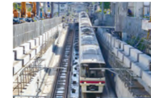
調布駅付近地下化切替工事
