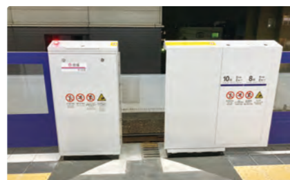
ホームドア車両間扉
