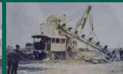
淀川の改良工事 （画像提供：国土交通省淀川河川事務所）
