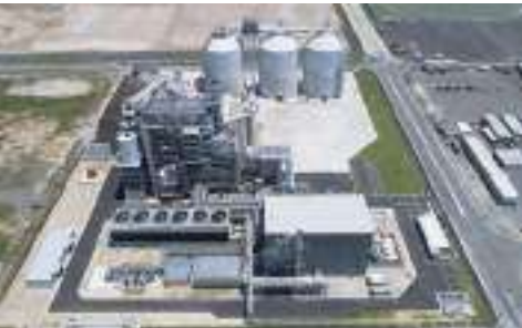
KONOIKEグループが関わったバイオマスプラントのタンク・配管工事
