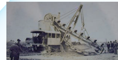
淀川の改良工事 （画像提供：国土交通省淀川河川事務所）
