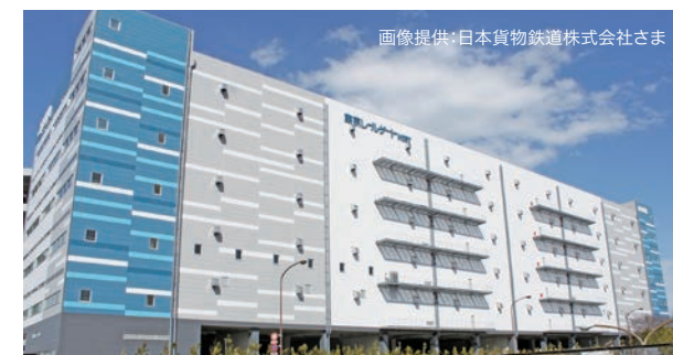
東京レールゲートWESTの外観
