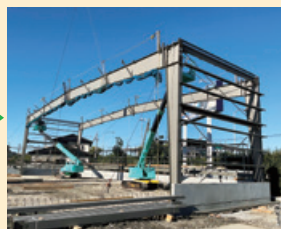
鉄骨組み上げ
