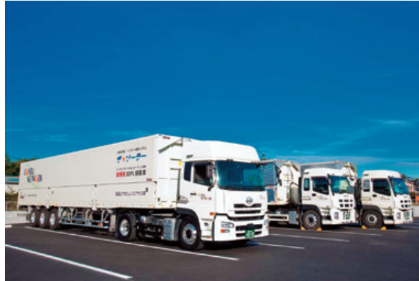
海老名第二駐車場拡張工事完了
