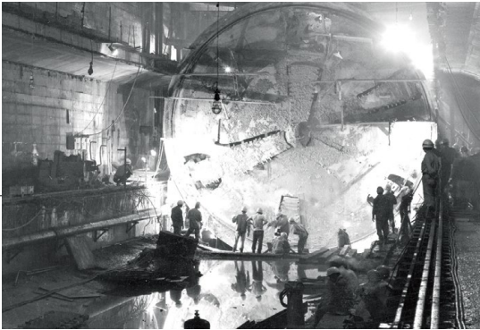
難波地下線建設工事の様子（1969年）
