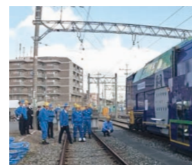
作業車を用いた軌道復旧訓練
