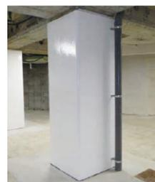
耐震補強工事後の高架橋柱
