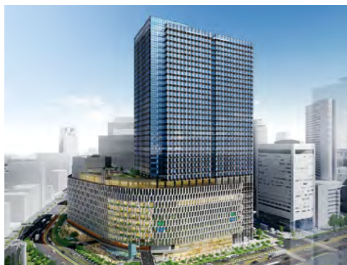
大阪梅田ツインタワーズ・サウス(2022年春 全体竣工予定) 阪急・阪神が保有する2つのビルを一体的に建て替えた経営統合の象徴とも言うべきプロジェクト
