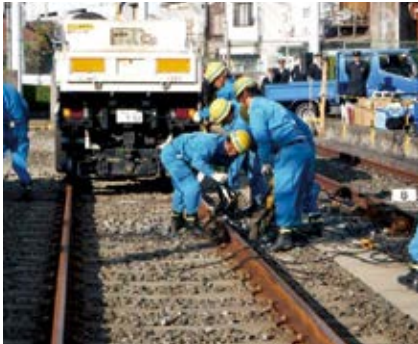
復旧作業訓練の様子
