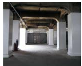
高架橋の耐震補強
