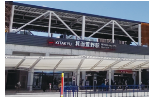
箕面萱野駅(高架駅)
