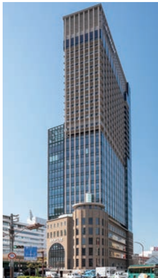
神戸三宮阪急ビルの外観(東側から望む)
