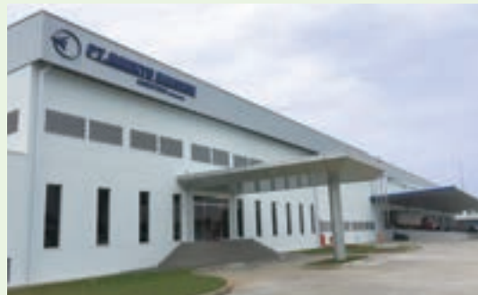
インドネシアの物流倉庫
