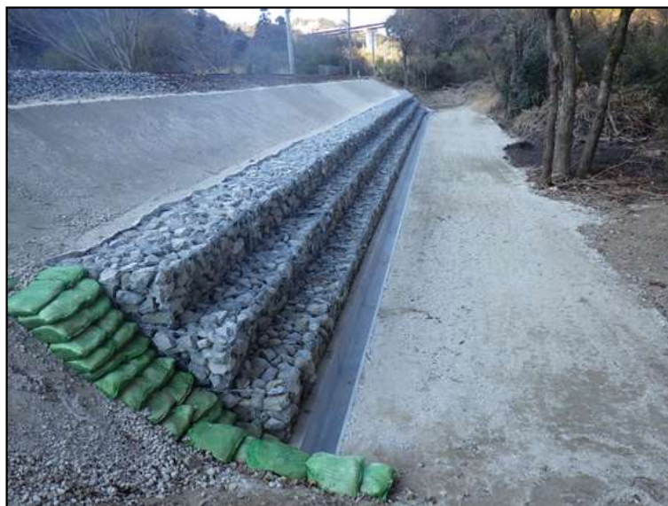
排水機能の強化工事(排水管路敷設及び排水整備工)
