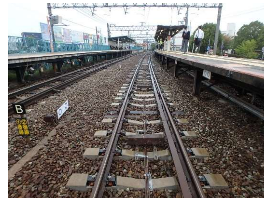
PC(プレストレスト・ コンクリート)枕木化
