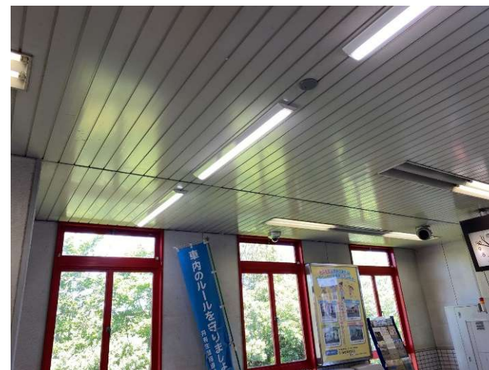
LED照明の導入・更新
