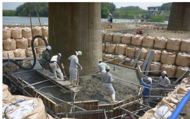
橋梁(橋脚)補強工事 →
