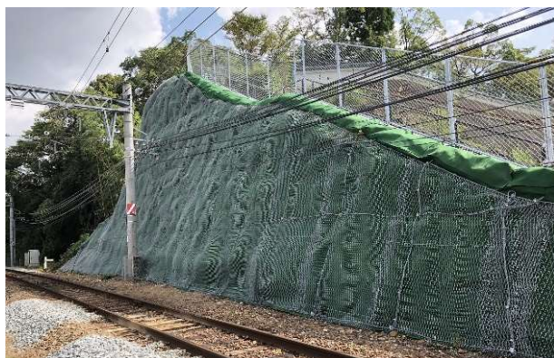
↑ 法面補強工事
