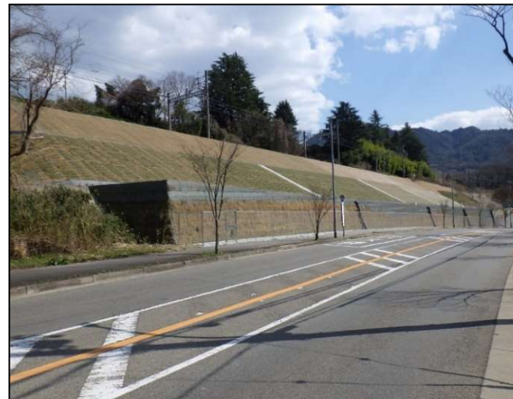
災害復旧を含めた線路敷法面の強化工事
