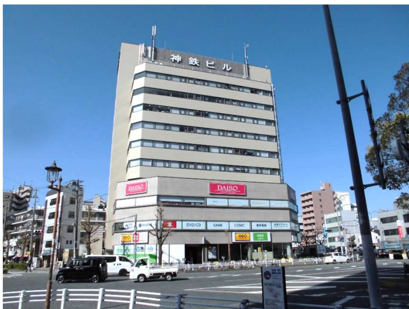
神鉄ビル(神戸市兵庫区)
