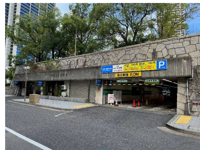
神戸市立三宮駐車場
