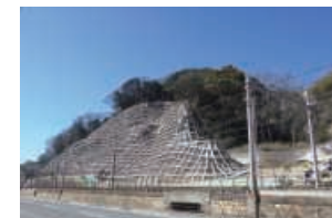
須磨浦公園駅～山陽塩屋駅間 法面防護工事
