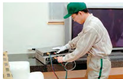
AV機器の配線取り付け
