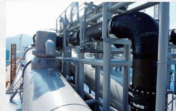
FSRUのデッキ上は複雑な配管。海水をくみ上げて再ガス化に利用する
