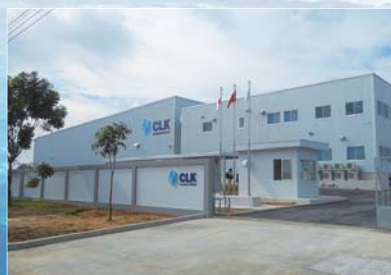
ベトナムの冷凍・冷蔵倉庫
