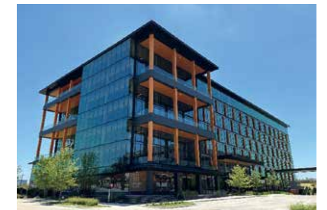
米国ダラス木造7階建てオフィスビルの外観
