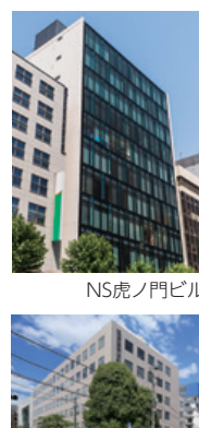
NS虎ノ門ビル 東京富士見ビル
