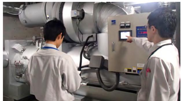
ターボ冷凍機（冷房用）の点検・調整
