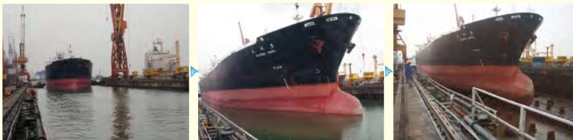
腐食の原因となる「錆」を落とし、船体の腐食を防ぐため塗料を塗り直す。
