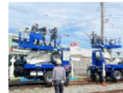
架線復旧作業
