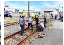
軌道復旧作業
