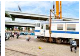
クレーンによる列車の載線
