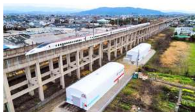
熊本市内に設置した第1号の蓄電施設
