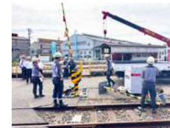
踏切復旧作業
