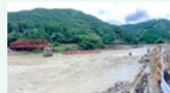
橋りょう流失
