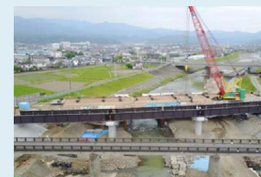
久大本線の復旧作業
